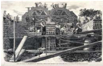
▲ 런던의 하수관거 건설공사
