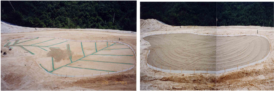
<그림 11> 골프장 그린시공(그린 망암거설치(좌) 및 그린 콩자갈 포설(우))
