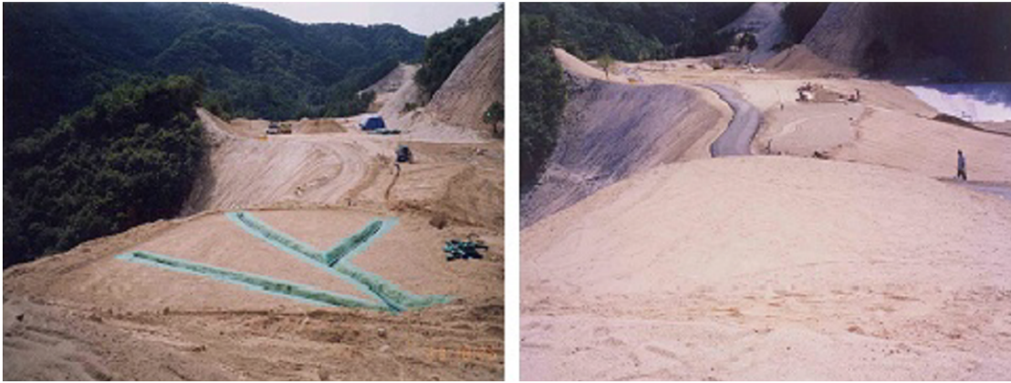
2) <그림> 골프장 티 시공(티 뱅암거 설치(좌) 및 티 상토 및 포설(우))*
