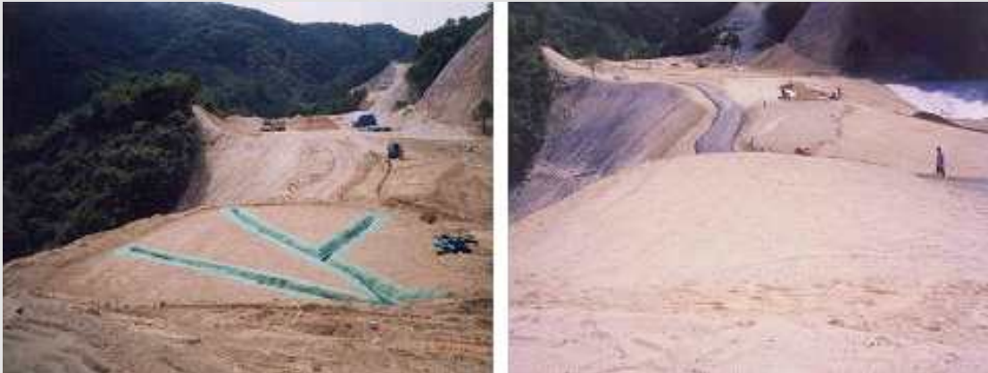
〈골프장 티 시공(티 망암거 설치(좌) 및 티 상토 및 포설(우))*〉
